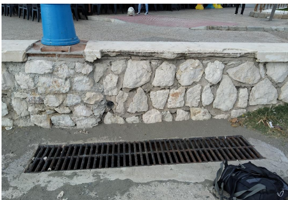
Rejilla de la playa, cegada, a donde van a parar las aguas pluviales de la plaza de Miguelito El Cariñoso.
