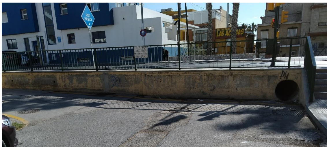
Salida actual de pluviales en calle Venezuela, con diámetro 800 mm.
